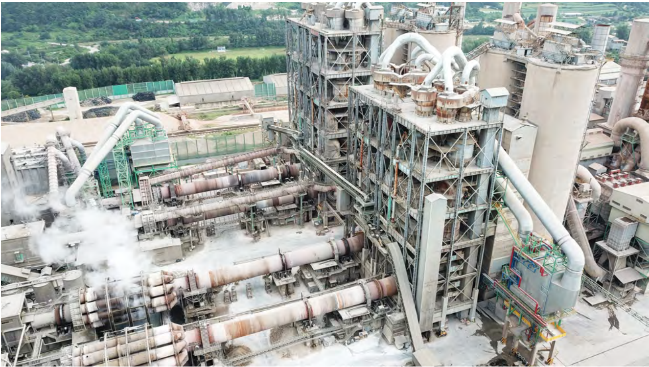
시멘트의 원재료인 석회석 등에 열을 가하여 클링커를 생산하는 킬른(가로 원통형 소성가마)과 예열실 전경. 오른쪽 하단의 은색 설비가 보일러다.
